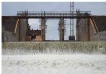
NHÀ MÁY THỦY ĐIỆN ĐAKR'ITI
